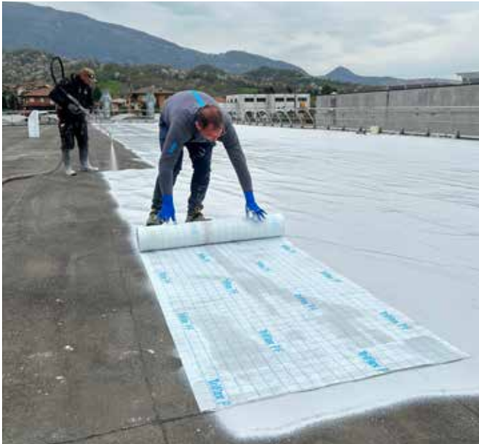
Impermeabilizzazione della copertura con i sistemi Triflex, durante i lavori
