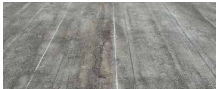
Copertura dello stabilimento di Cospal S.p.a. con guaina bituminosa, prima dell'intervento con soluzioni Triflex
